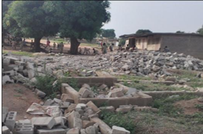
Photo 1 : Aperçu des agglos détruits et dispersés sur l'aire de construction
