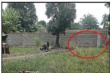
Photo 1a : Arrêt des travaux sur un chantier à Ahougnansou
