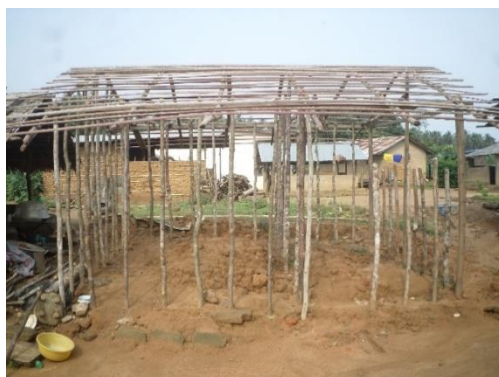
Photo 2. Construction de case à partir des matériaux en bois
